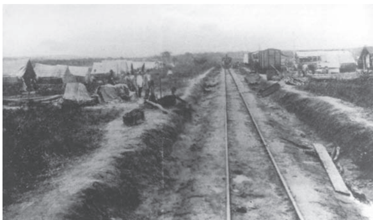
FIGURA 17 – Dormentes implantados diretamente sobre o solo. Foto do acampamento de trabalhadores localizado no quilômetro 298. Foto sem data (Centro de Memória Regional, RFFSA/UNESP. Bauru, SP).
