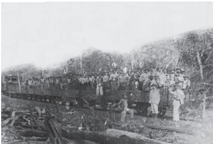
FIGURA 12 – Trabalhadores sobre o trem de lastro durante a construção da CEFNOB. Foto de 1905 (Centro de Memória Regional RFFSA/UNESP. Bauru, SP).
